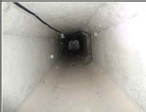
거더 내부 전경
